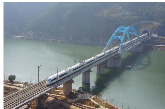
Abb. 6: Messdatenerfassung in rauen Umgebungen – Hochgeschwindigkeitstrassen mit Brücken und Tunneln.
