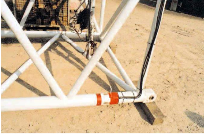
Abb. 5: Montage der Messeinrichtungen an einem Gittermastteil am Boden vor dessen Einbau in den Kran.
