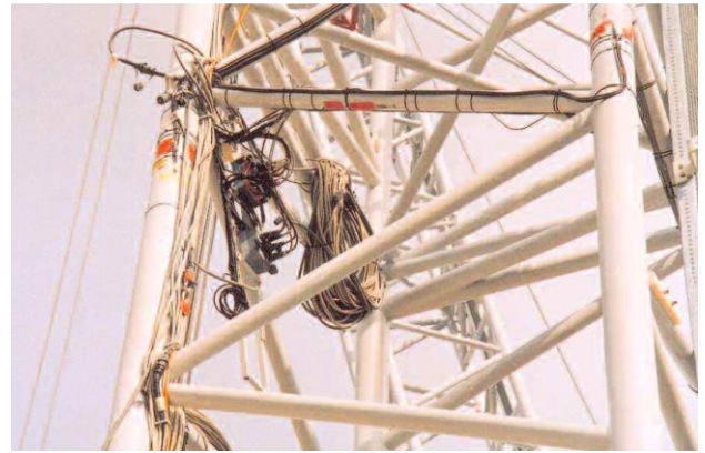
Abb. 6: Messquerschnitt am Gittermast mit DMS an den äußeren Gurtrohren und Diagonalen, links sind die Geräte zur Signalverarbeitung erkennbar
