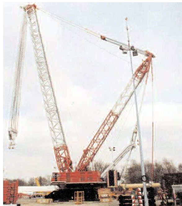
Abb. 1: Terex-Demag Mobilkran mit einer maximalen Traglast von 1250t.
